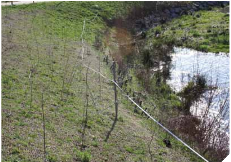
Trabajos de medición del grado de cobertura de vegetación sobre talud con diferentes técnicas de bioingeniería
