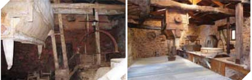
El molino fue utilizado para la molienda con carácter industrial, por lo que se acompaña de estructuras de envergadura para la captación, canalización y almacenamiento de agua. Se ha restaurado la estructura del molino, su cerramiento exterior, y el sistema de aprovechamiento de la energía potencial hidráulica para la molienda, además se ha acondicionado el aspecto interior y exterior del molino para su mejor acceso e interpretación.
