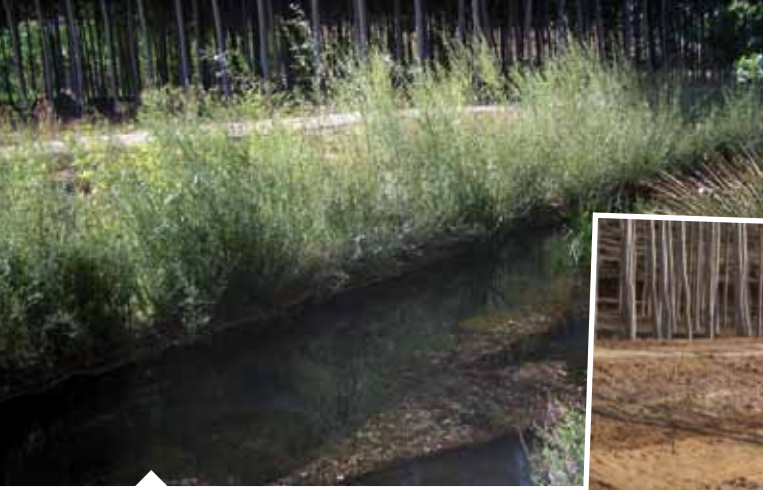
Empalizada trenzada, manta orgánica, estaquillado y plantación en el río Piedra en Llumés (Zaragoza) recién ejecutados los trabajos y tras un año
