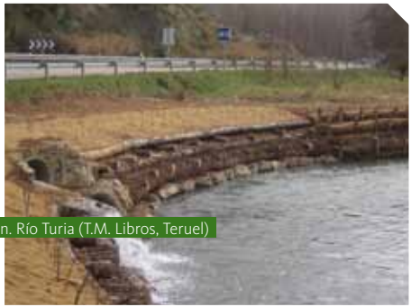
Obra recién terminada —muro Krainer y empalizada de biorrollos— y situación a los siete meses de finalizar
