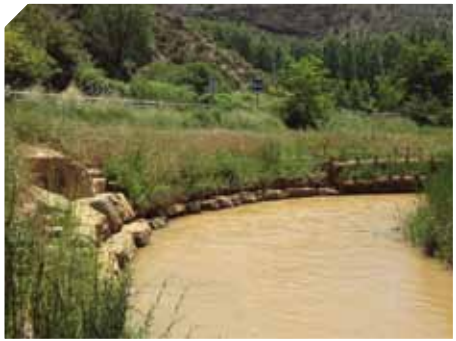
Obra recién terminada —muro Krainer y empalizada de biorrollos— y situación a los siete meses de finalizar
