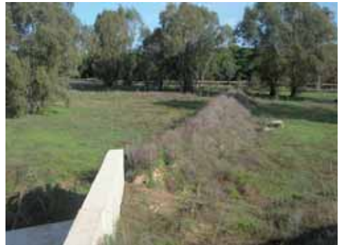
Figura 5. DIQUE 2. Fotografías superiores: Vistas del dique construido en el arroyo de la Cañada del Pinar, inmediatamente aguas arriba del puente sobre el mismo del camino asfaltado entre El Rocío y Villamanrique. Fotografías inferiores: A la izquierda detalle de los muros laterales de hormigón que conforman el vertedero del dique. A la derecha la prolongación del muro de hormigón por otro de tierra, para encauzar la corriente hacia el mismo y evitar que se pueda desviar hacia el paso de fauna situado por debajo de la carretera.
