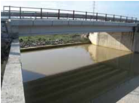
Figura 5. DIQUE 2. Fotografías superiores: Vistas del dique construido en el arroyo de la Cañada del Pinar, inmediatamente aguas arriba del puente sobre el mismo del camino asfaltado entre El Rocío y Villamanrique. Fotografías inferiores: A la izquierda detalle de los muros laterales de hormigón que conforman el vertedero del dique. A la derecha la prolongación del muro de hormigón por otro de tierra, para encauzar la corriente hacia el mismo y evitar que se pueda desviar hacia el paso de fauna situado por debajo de la carretera.
