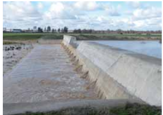
Figura 12. DIQUE 1 tras la rectificación del perfil de su vertedero frontal, operativo en enero de 2009. Fotografía de la izquierda: tal como se encontraba el 6-06-2009. Fotografía de la derecha: operativo a las 13:00 horas del día 2-02-2009, tras la avenida iniciada en la tarde-noche anterior (imagen cedida por C. URDIALES, PND).
