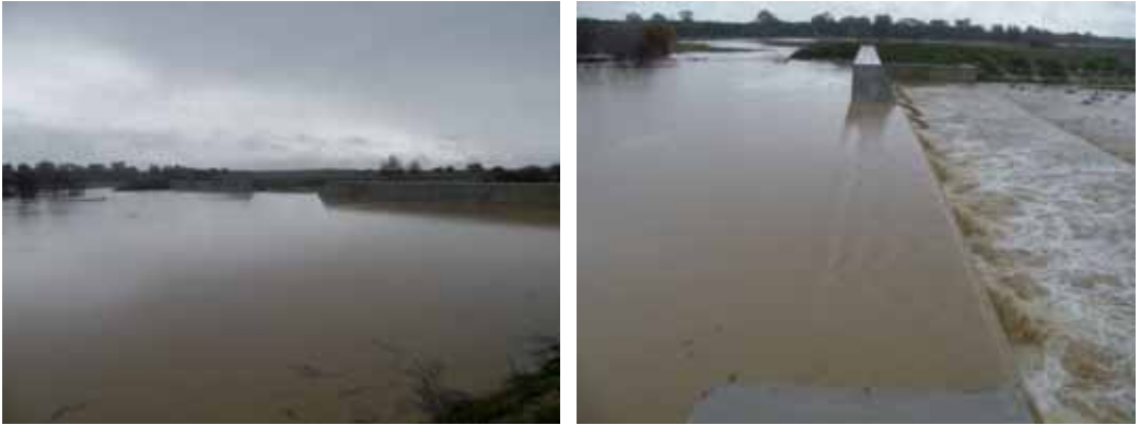
Figura 16. Estado de la avenida del arroyo del Partido en el DIQUE 1 a las 13:10 horas locales del día 5-02-2009. Según el hidrograma de avenida la descarga en el arroyo del Partido en ese momento estaría en torno a los 65 \text{ m}^3 \cdot \text{s}^{-1} . Izquierda: panorámica del sistema de reparto de los caudales entre los vertederos frontal y lateral. Derecha: detalle del paso de la corriente por el vertedero frontal, por el que se estima que están descargando unos 20 \text{ m}^3 \cdot \text{s}^{-1} ( 15 \text{ m}^3 \cdot \text{s}^{-1} por los mechinales y el resto por el umbral del vertedero). Fotografías C. URDIALES, PND.
