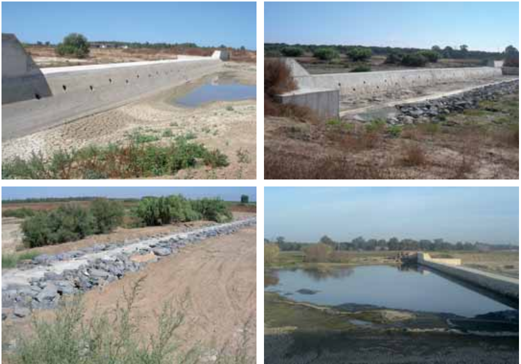
Figura 2. DIQUE 1 construido en el arroyo del Partido al inicio de su antiguo cono de sedimentación, que constituye el elemento director del esquema restaurador de la Actuación núm. 3 del Proyecto DOÑANA 2005. Fotografías superiores: vertedero frontal, con el perfil original de 2006, visto desde aguas arriba (izquierda) y desde aguas abajo (derecha). Fotografías inferiores: Vertedero lateral del dique, detalle (izquierda) y panorámica desde aguas arriba (al fondo de la imagen derecha).
