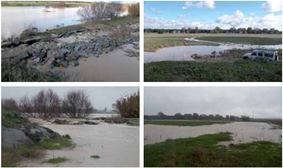
Figura 19. Situación generada por las avenidas del arroyo del Partido en el vertedero lateral del DIQUE 1 y en el área de inundación-laminación establecida en la Actuación núm. 3. Fotografías superiores: a las 13:40 horas locales del día 2-02-2009. Fotografías inferiores: a las 13:20 horas locales del día 5-02-2009. Imágenes de la izquierda: vertedero lateral del DIQUE 1. Imágenes de la derecha: inundación en el área reservada al efecto, que se adecua a la topografía definida por los antiguos derramaderos existentes en el lugar. (Fotografías C. URDIALES, PND).
