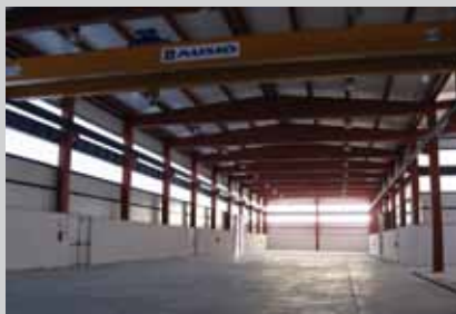
Interior de la nave para reparación de redes.
