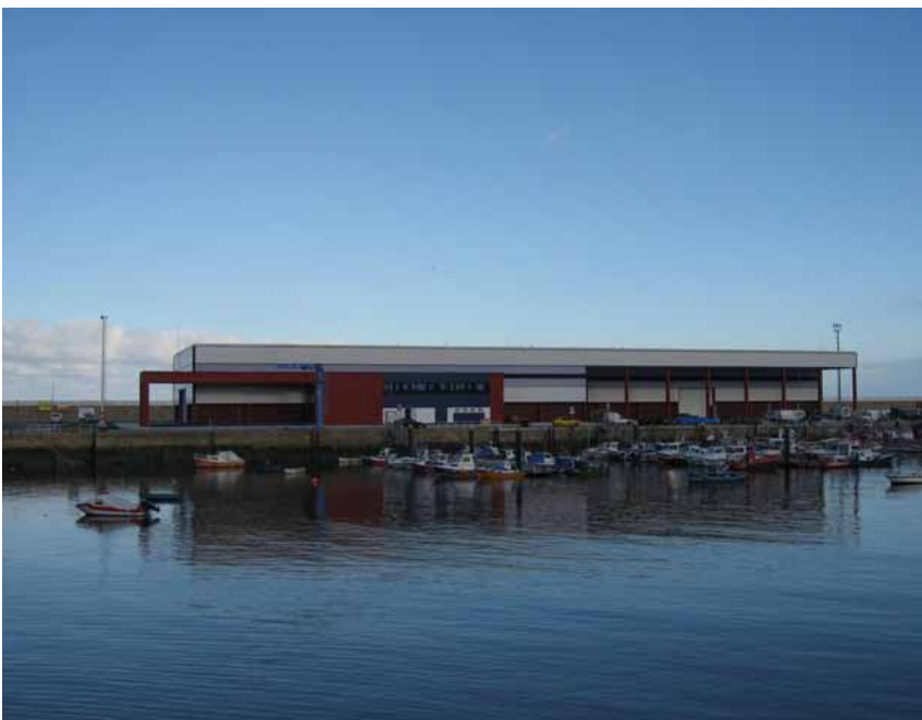
Vista exterior de la nave para reparación de redes.
