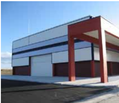
Situación en el puerto de la nave de reparación de redes.
