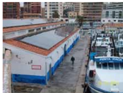
Placas fotovoltaicas situadas en la lonja.
