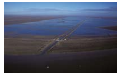
Vista aérea desde la toma de agua.
