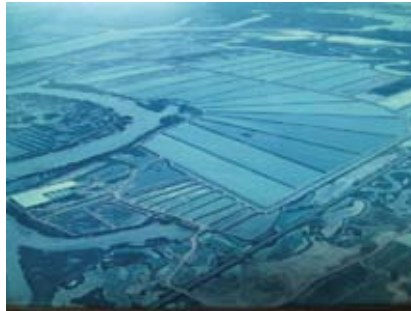
Vista general de la instalación de Maresa.
