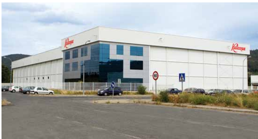
Instalaciones de Monte Kalamua.
