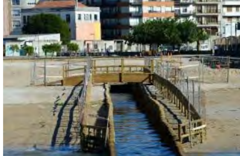
La canalización discurre a cielo abierto en la desembocadura, protegida por pivotes de madera. // Noé Parga
