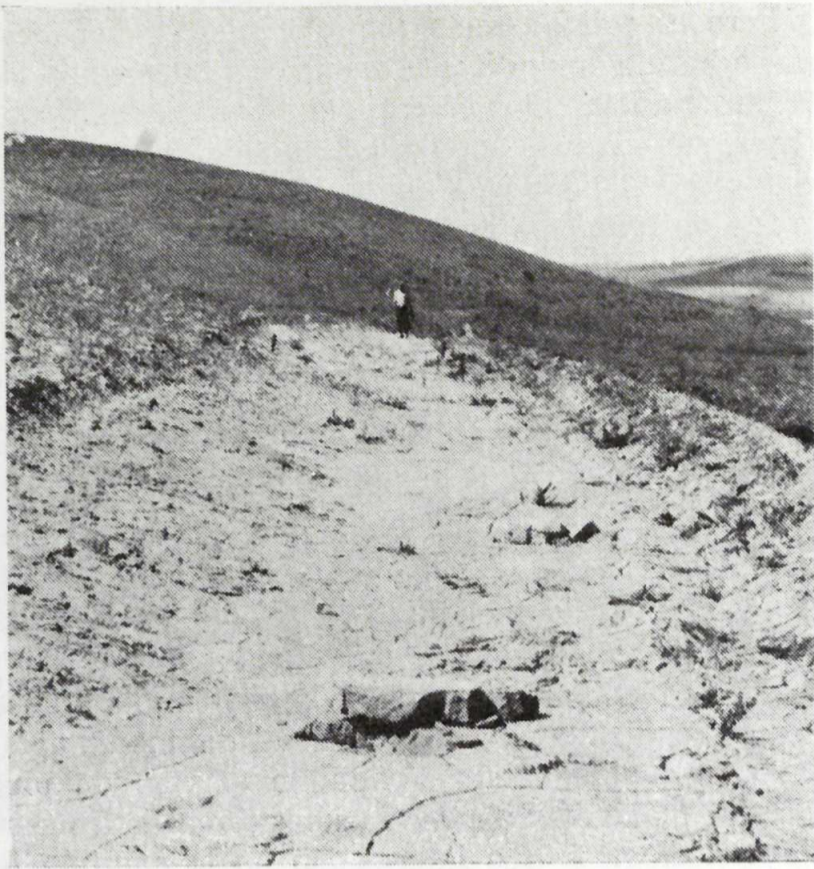
Canal de una terraza que ha detenido los sedimentos tras una tormenta.
