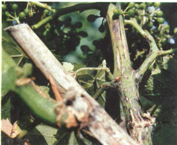
Sarmiento verde afectado mostrando las típicas grietas.
