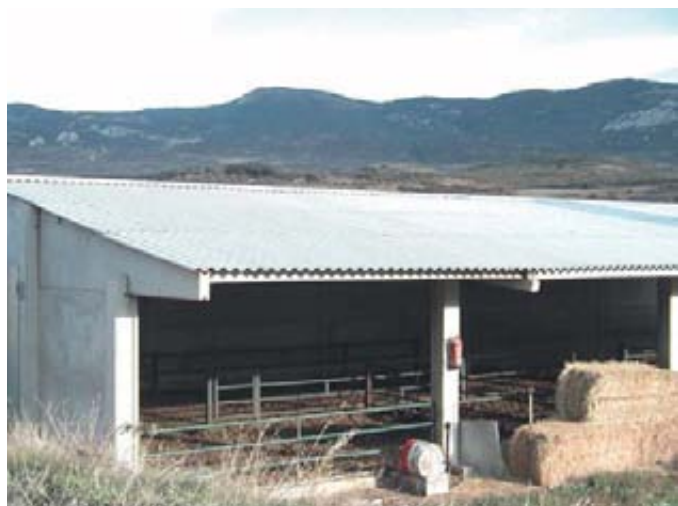
Foto 1. Cebadero de terneros con paramentos de fachada abiertos.
