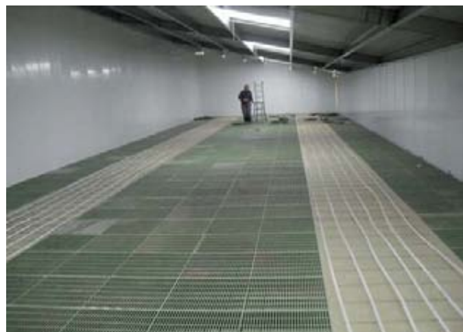
Foto 2. Calefacción por suelo radiante en una granja de transición a cebo de porcino.
