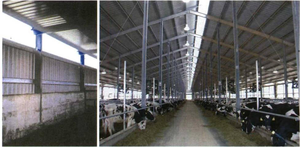
Figuras 2 y 3. Debe proporcionarse una suficiente entrada de aire, evitar corrientes de aire y un gran volumen en las instalaciones.
