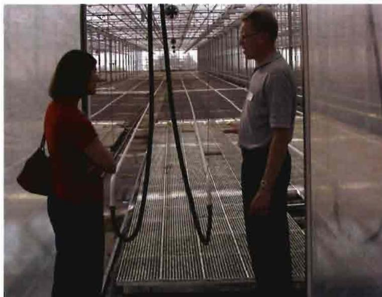
**Nave de un invernadero de Markvart, en el que se han instalado, de manera provisional, unos tubos de PE para calentar mediante agua, arena, recubrimiento de plástico y malla cubresuelos.**
