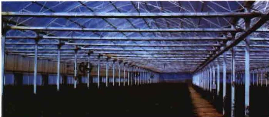
Suntuf Plus son placas de policarbonato corrugado con control de condensación incorporado, fabricadas por Pal Plastic, S.A para la cubierta de invernaderos. Transmite el 90% de la luz visible (mejor que el cristal y mucho mejor que cualquier otro material de acristalamiento). Más luz, significa un desarrollo más rápido de los ciclos de crecimiento, mayor calidad y mayor producción.
