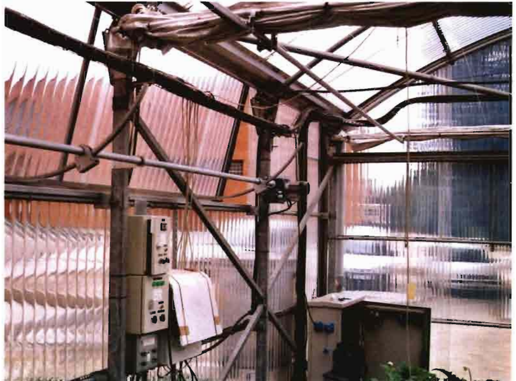
La ventana lateral recorre toda la longitud del invernadero.
