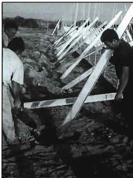
A la izquierda de estas líneas, colocación de pies metálicos en banda. En el centro, trabajo de perforadora en la construcción de invernaderos. Abajo, colocación de tirantes en abanico en bandas
