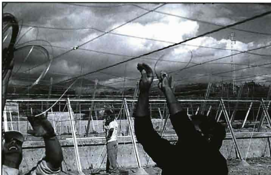
Construcción de cerramiento (enmallado) sobre el que se colocará la cubierta
