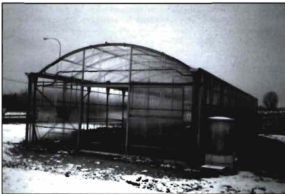
Vista invernal, tras una nevada, del invernadero experimental, situado en los campos de prácticas de la E.T.S.I. Agrónomos de Madrid. En su interior, como se observa en la fotografía, se cultivan gerberas en contenedores sobre el suelo.
