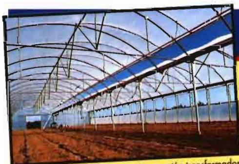
\* Los plásticos tricapa están transformados por máquinas de coextrusión.
