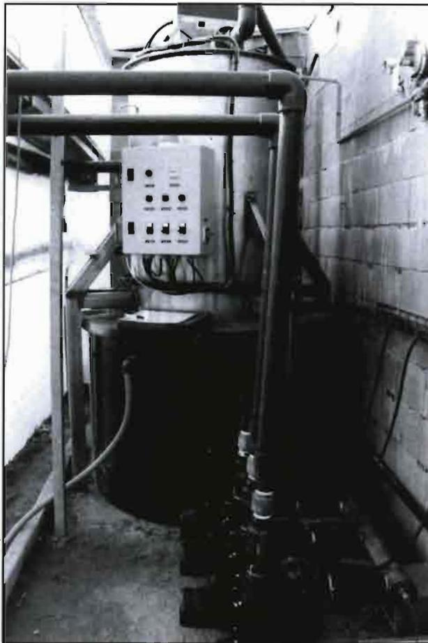
Sistema de calefacción con propano para un cultivo de Liliium en Mataró (El Maresme, Barcelona). En la foto derecha detalle de la caldera, de condensación, de 300 Kw, y en la foto inferior panorámica de la explotación, con los tubos coarrugados elevados para concentrar el calor al lado de la planta.
