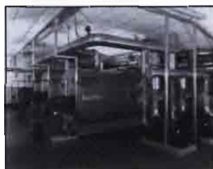
Instalación de calefacción.
