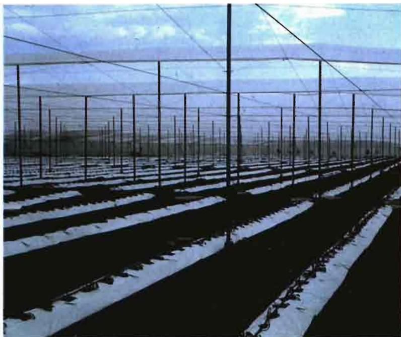
Invernadero tipo «parral» con estructura metálica y cubierto con malla preparado con sacos de cultivo de arena en Aguilas (Murcia).
