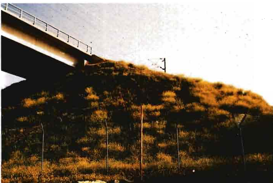
Arriba, talud en la línea del TAV antes del tratamiento. Debajo, el mismo talud, ya vallado con el resultado de una hidrosiembrado.
