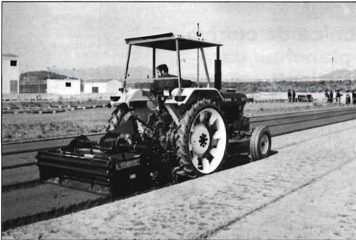
Apero para preparado, alisado y embancado del terreno. (Foto 2).
