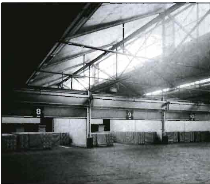
Serie de celdas de refrigeración de rápido enfriamiento. Al fondo cajas de pepino empaquetadas con una temperatura de expiración controlada de 10 °C. Para una rápida entrada y salida de los productos se hace uso de puertas elevadizas a todo lo ancho de la cámara. Fotos de cámaras Filacell.
