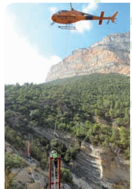
Construcción del puente sobre el río Noguera Ribagorzana que enlaza Lleida y Huesca en el camino natural de Montfalcó al Congost de Mont Rebei.
