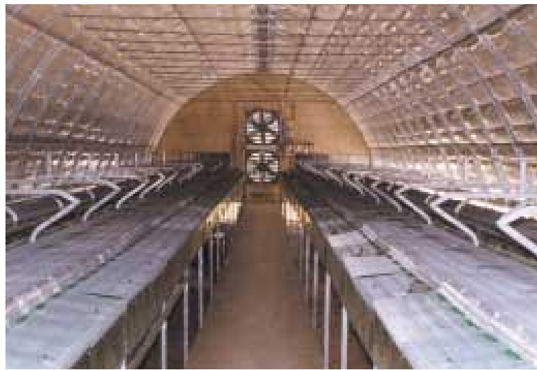
Nave en construcción con ventilación horizontal longitudinal por depresión.
