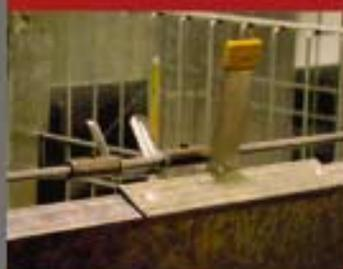
Detalle de **trampilla desactivada**. Basta con levantar la leva 1
