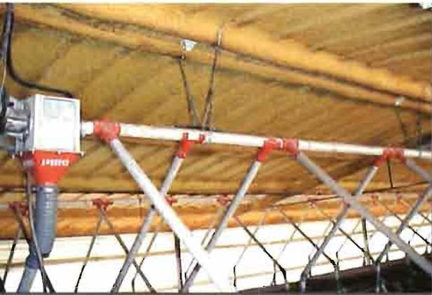
Fig 1.- Granja cunícola en que se ha instalado una inyección de espuma de poliuretano, para aislar el tejado en una zona situado en un área de clima seco continental que en verano sus temperaturas superan muchos días los 37° C
