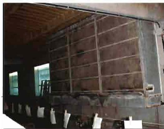
Fig 5.- Sistema de enfriamiento por paneles humidificadores al acceder mecánicamente el aire hacia el interior de la nave. Este sistema puede reducir la temperatura hasta 6°C y exige que los paneles estén constantemente húmedos.
