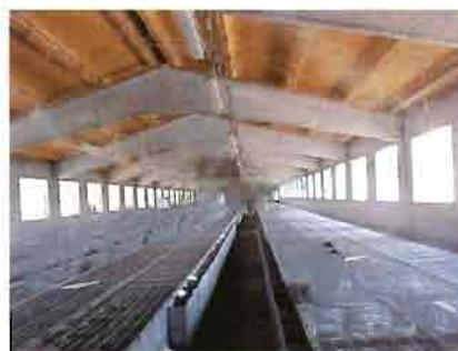
Fig 3.- Nave con ventilación natural, con grandes ventanales y considerable altura. Este conejar está situado en la comarca de Les Garrigues (Lleida) y además del aislamiento, dispone de sistema de humidificación por aspersión, cuando la temperatura desciende de 25°C.
