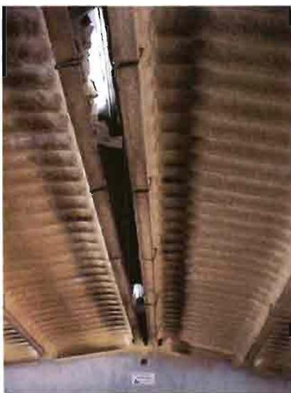
Fig 4.- Es indispensable las naves para cria natural dispongan de aberturas zenitales, para expulsar el aire cálido ascendente. En algunas granjas esta salida es auxiliada con ventiladores a nivel superior
