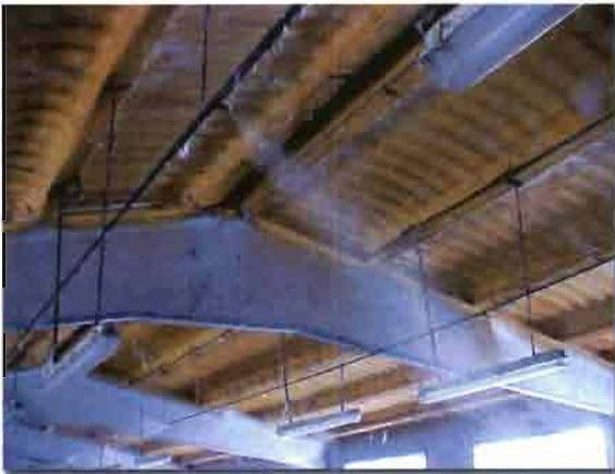
**Fig 6, 7 y 8.-** Sistema de refrigeradores por aspersión. Este sistema se acciona mediante un compresor, con boquillas a lo largo de la nave. La presurización produce una dispersión de agua con efecto refrigerante rápido y eficaz. Exponemos algunas imágenes de este sistema en funcionamiento.
