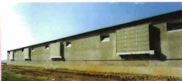
Módulos para refrigeración por depresión
