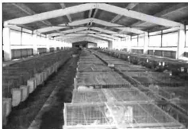
Interior de una de las 12 naves.
