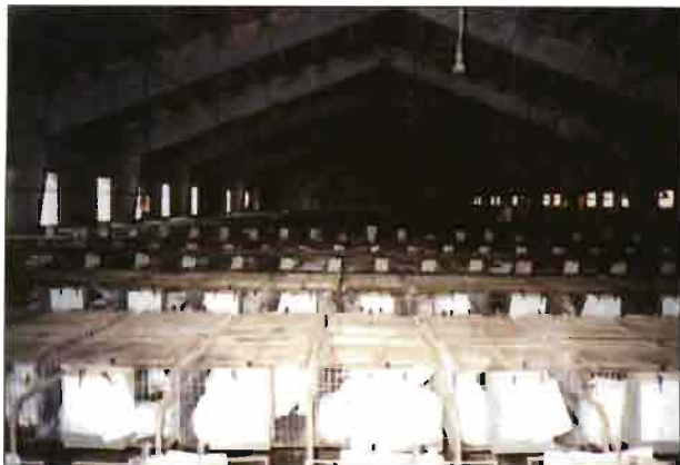
Vista interior nave de producción integral.
