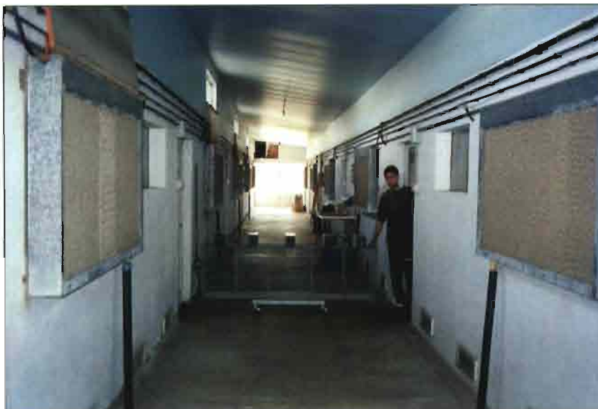
Vista del interior de un módulo.
