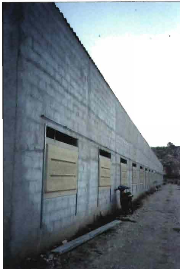
Fachada principal de la nave.
