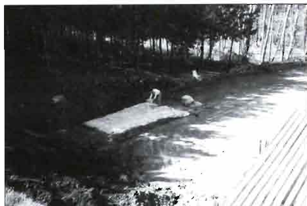
Preparación de la base del silo.
