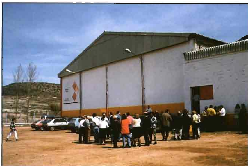
Aspecto exterior del nuevo matadero de conejos.
