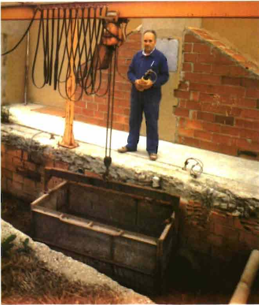
Detalle del foso exterior de deyecciones, con separación de sólido y líquido. Los excrementos secos son comercializados para elaboración de abono orgánico.
