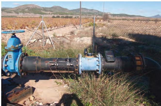
Salida de un pozo con caudalímetro de ultrasonidos
