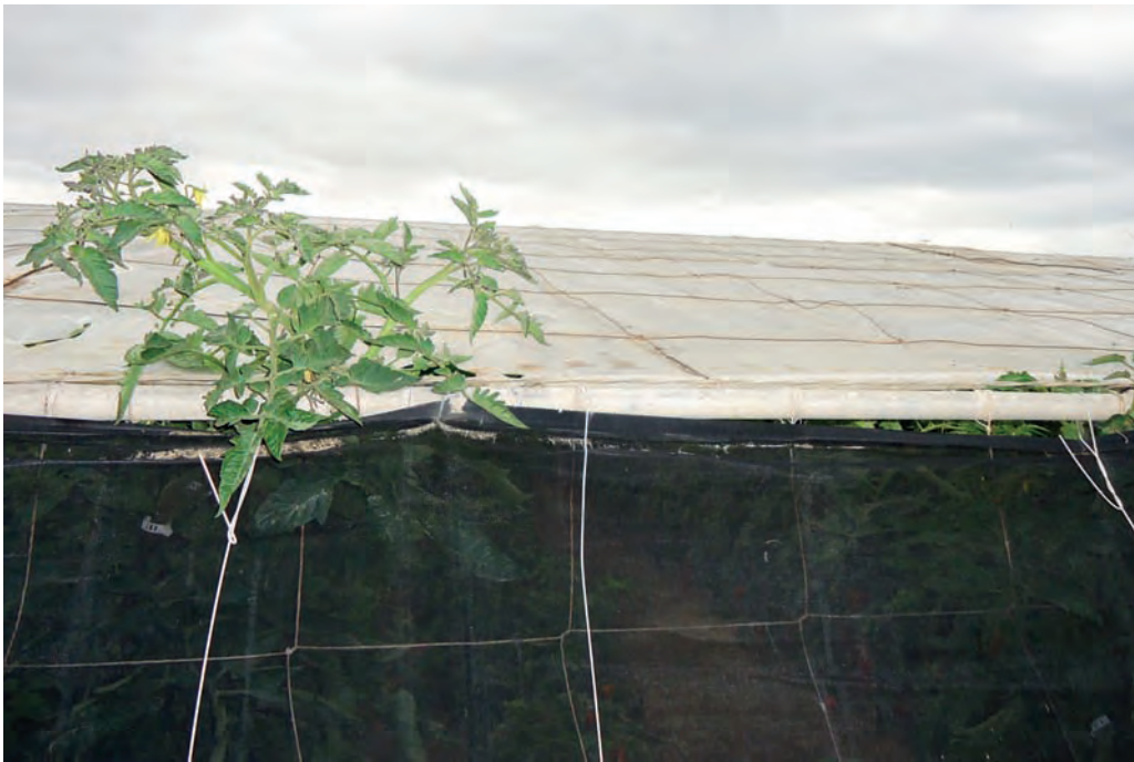
Cubierta de un invernadero
