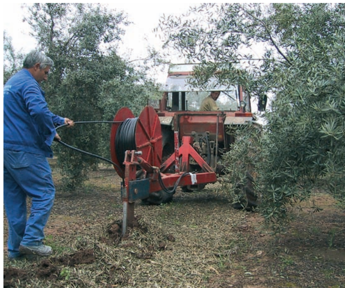
Instalación de tubería con gotero integrado para riego subterráneo en campo de ensayo de Valdecastro (Linares, Jaén).
