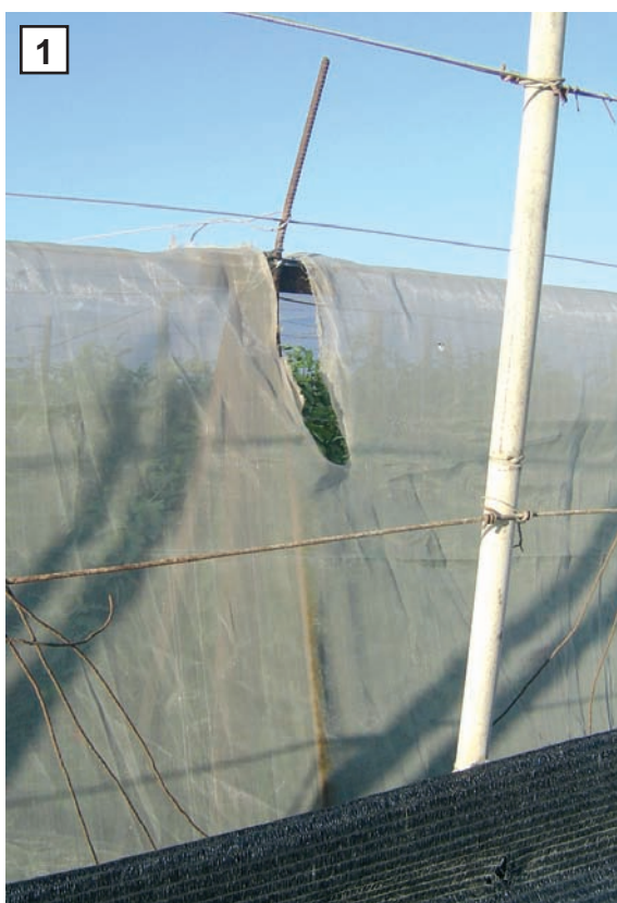
Rotura de malla en invernadero
