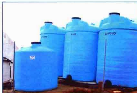
Depósitos de PE utilizados para almacenar fertilizantes líquidos para la fertirrigación del olivar. El depósito pequeño está destinado al almacenamiento de ácido nítrico, indispensable para el mantenimiento de un adecuado pH del agua a la salida de goteros
