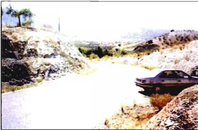
Impactos inevitables para cumplir la exigencia técnica de pendiente máxima (8%)
