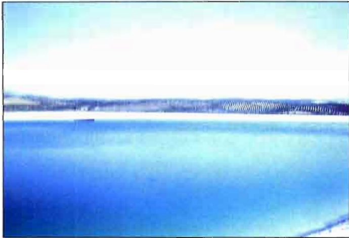
En los riegos con aguas procedentes de los ríos, o aprovechando caudales intermitentes, es normal el empleo de balsas reguladoras de gran capacidad recubiertas interiormente de material impermeable (PVC en este caso), que aseguran el riego durante el verano. Balsa de 400.000 m 3 de capacidad en una comunidad de regantes de Torreperogil que riega 1.600 Has con agua procedente del río Guadalquivir
