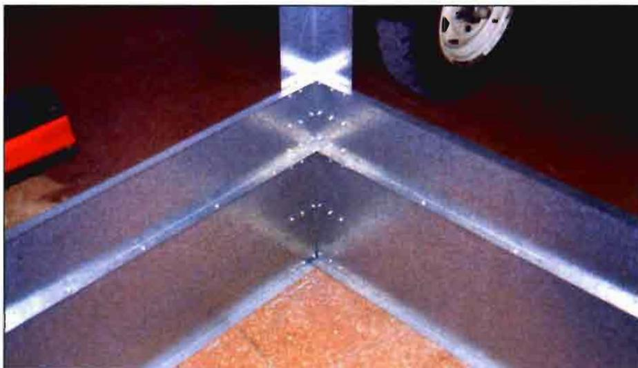
Figura 1.- Placas conformadas de acero galvanizado.
