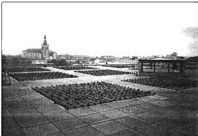
Azotea aljibe instalada en el Ayuntamiento de Getafe (Madrid).
