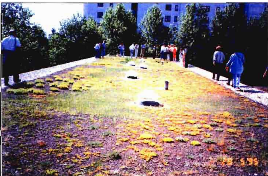
Cubierta ajardinada. Ensayo de adaptación de especies vegetales y técnicas de construcción en Madrid. (Foto: Isabel de Felipe).
