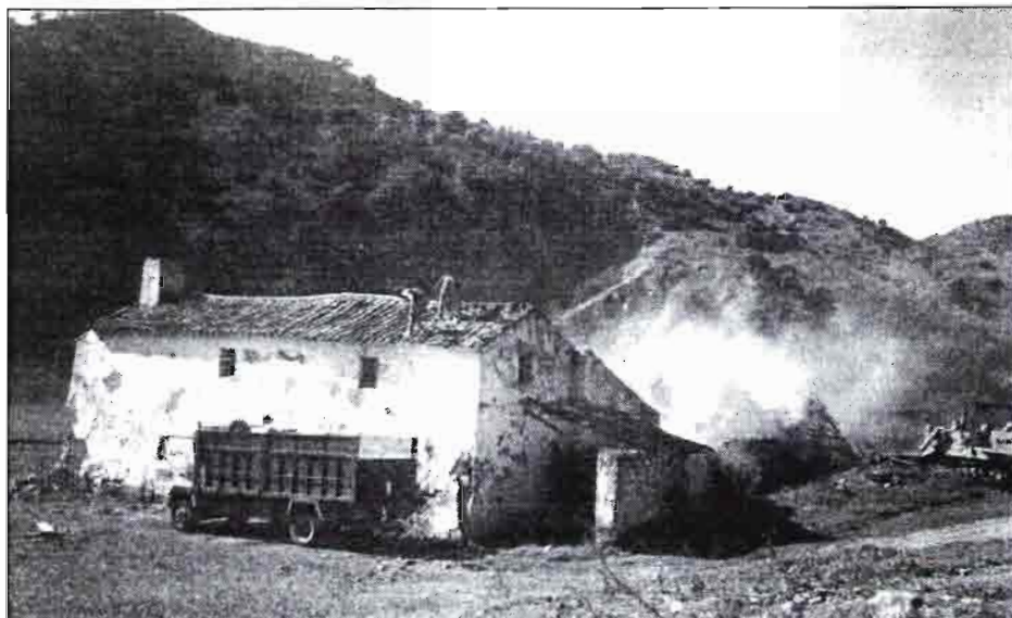
Caserío, ya abandonado, en el momento de su demolición tras la correspondiente expropiación de las tierras, para la construcción del pantano de la Puebla de Cazorra (Sevilla), terminado en 1993
