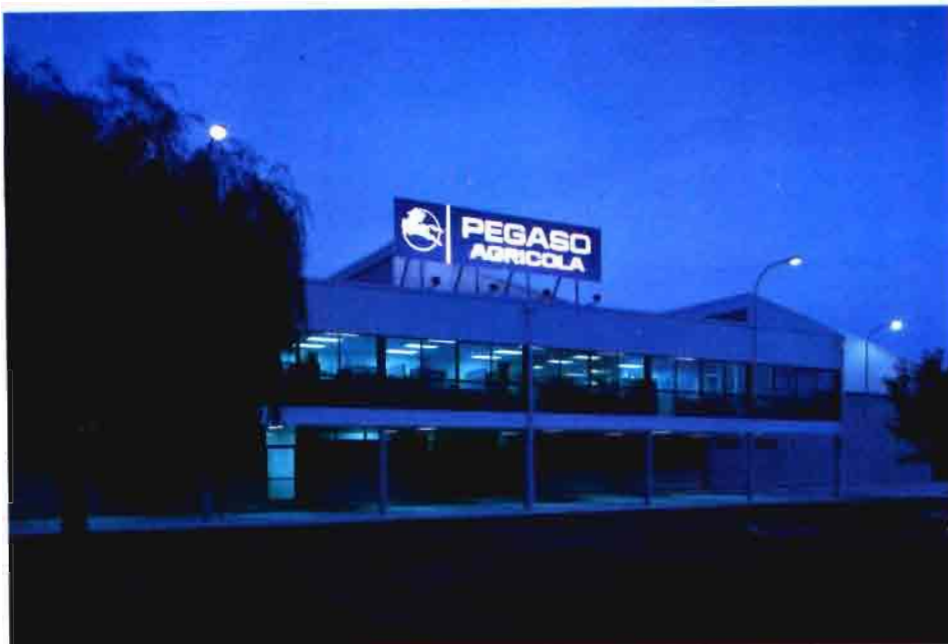
Oficinas en Barcelona, Zona Franca.
