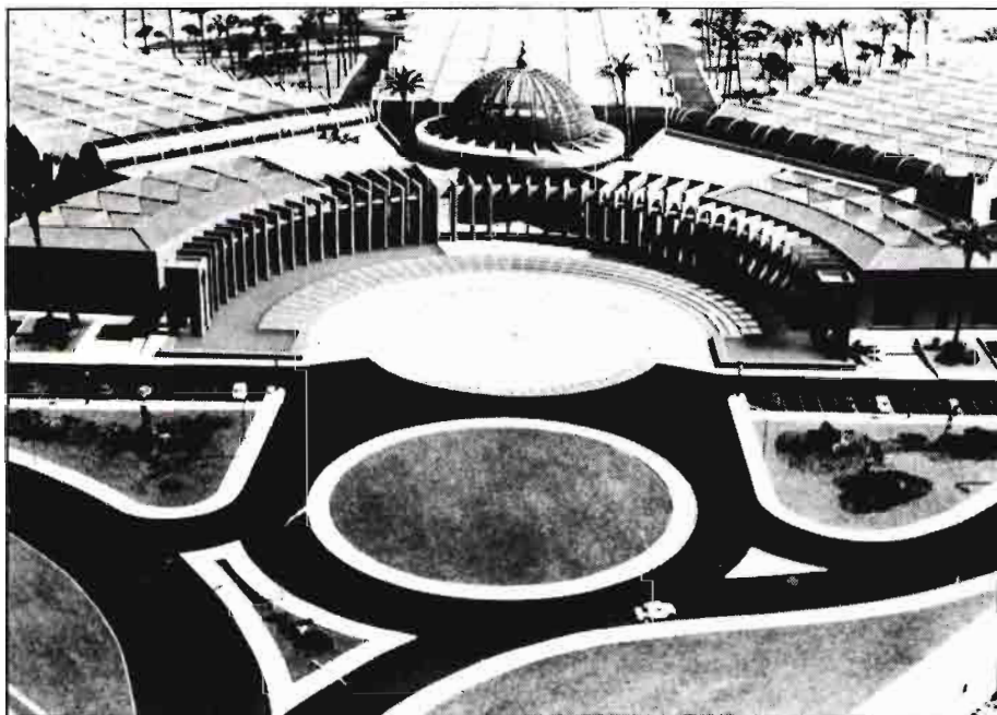
Maqueta del magnífico Palacio de Congresos y Exposiciones de Sevilla, actualmente en fase muy avanzada de construcción, y que será inaugurado el día 9 de octubre próximo, con motivo de la celebración de la "Agromediterránea'87".
