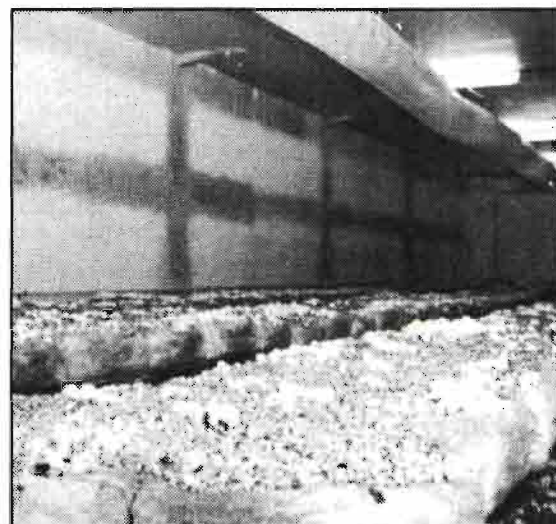
Detalle de la cubierta de las naves de cultivo de champiñón, aisladas térmicamente con planchas de espuma de poliestireno extruido STY-FOROAM* SM-TG de 4 centímetros de espesor.
